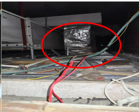
图 1-4 裸露的导线端头
