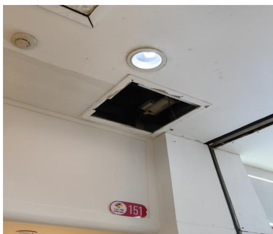
图 1-1 吊顶检修口
