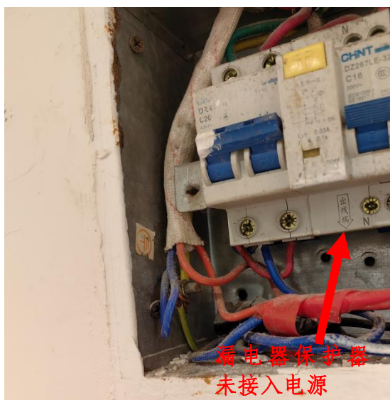
图 2-5 漏电保护器未接入电源
