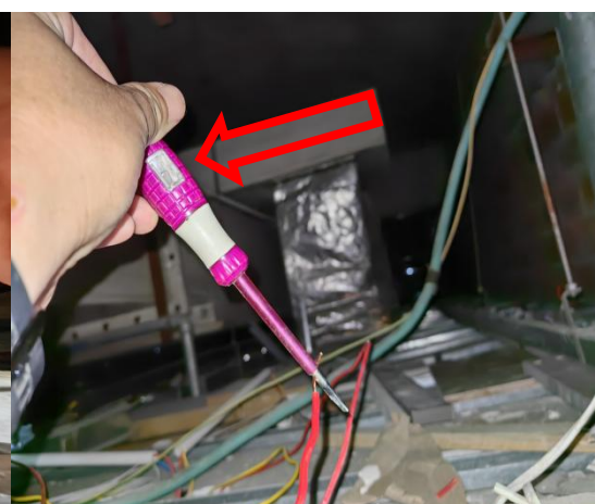
图 1-6 东侧导线不带电
