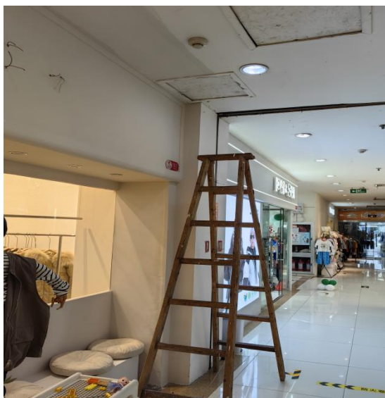
图 1-7 事故现场木梯
