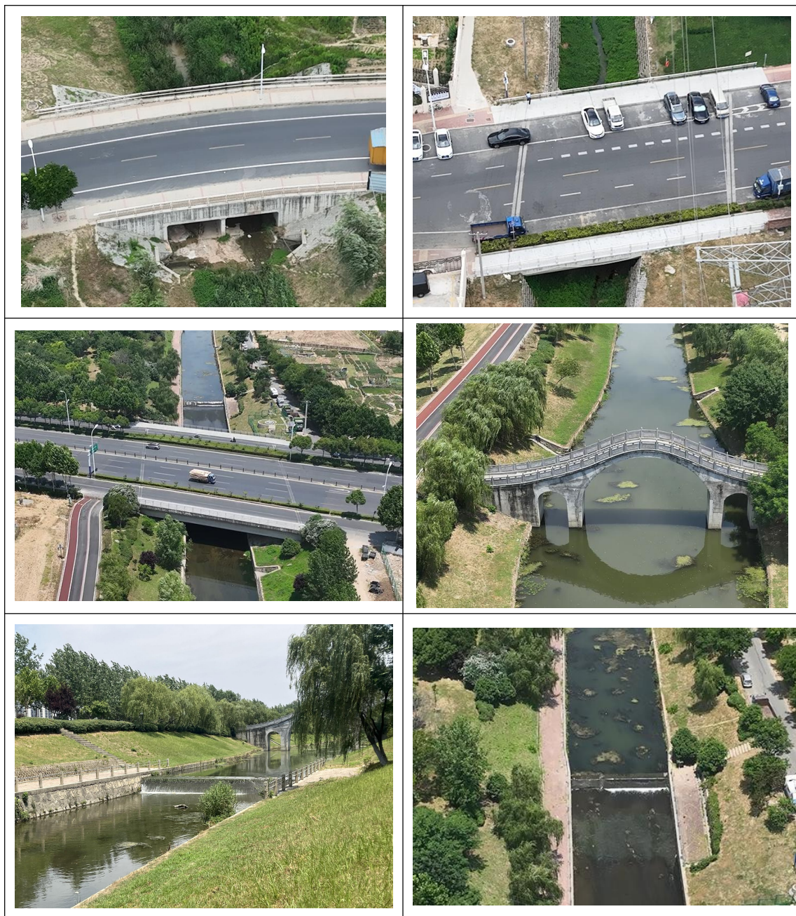
图 1-3 小板桥河涉河建筑物现状图
