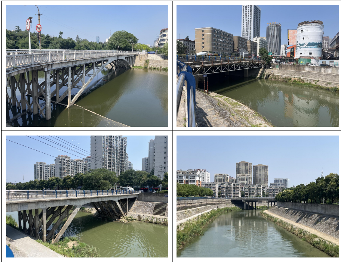
图 1-3 板桥河涉河建筑物现状图
