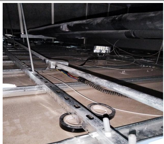
图 3-6 吊顶施工作业物品
