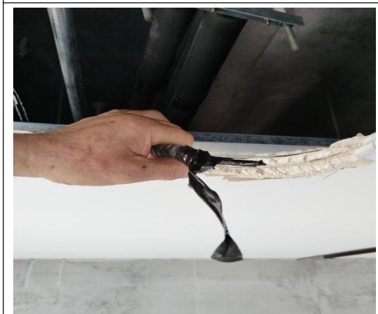
图 3-7 筒灯线路末端状态
