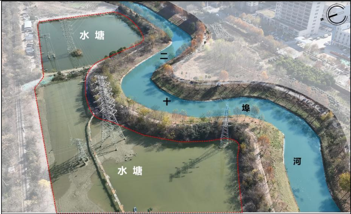
图 3-11 现有坑塘现状
