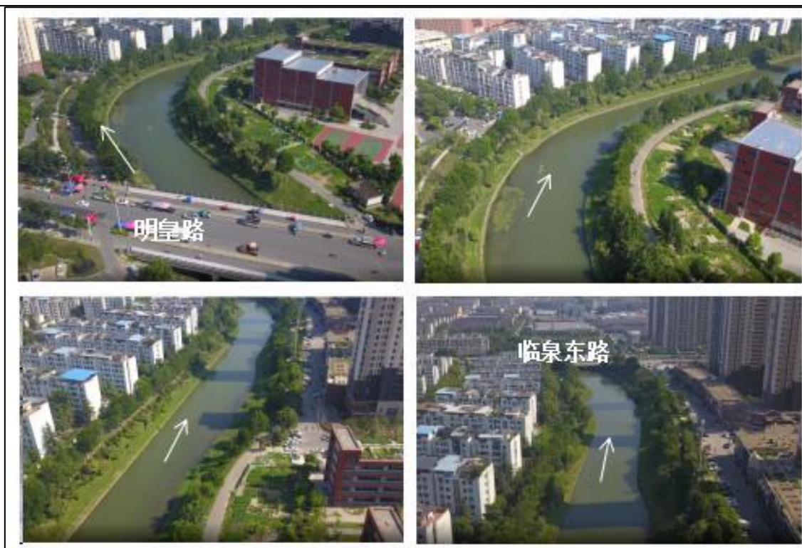
图 3-1 二十埠河（明皇路~临泉东路）段河道现状
