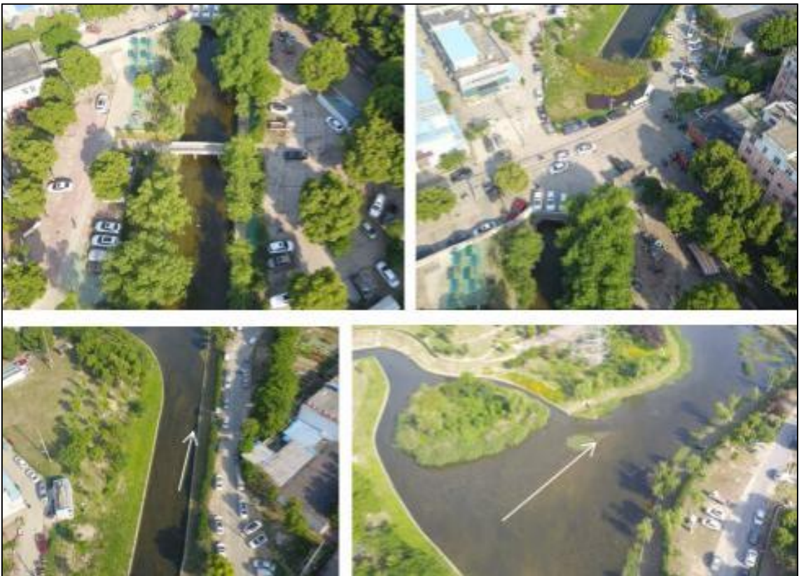
图 3-6 小板桥河（临泉东路~长江东路）段河道现状
