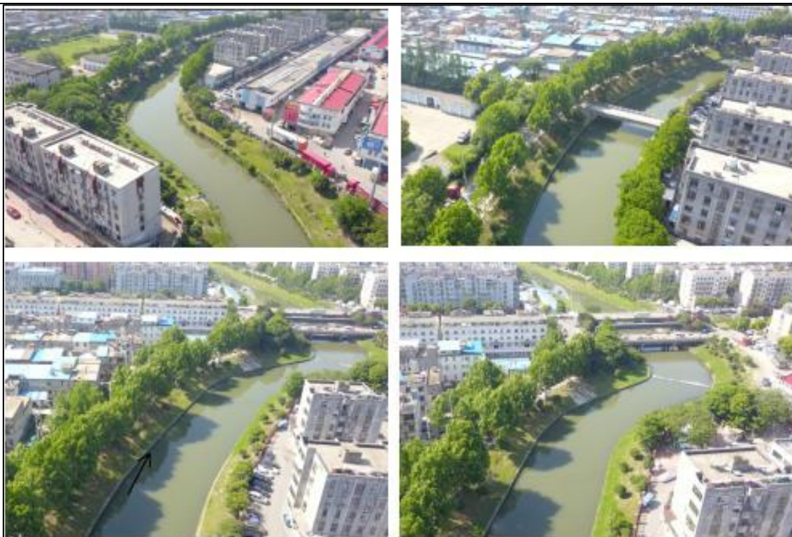
图 3-3 二十埠河（广德路~襄河路）段河道现状
