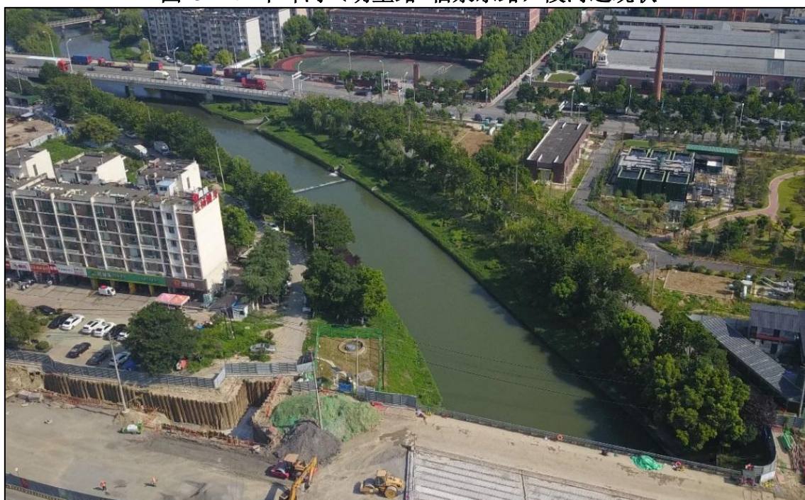
图 3-2 二十埠河（临泉东路~广德路）段河道现状
