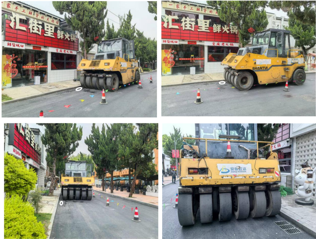
图3 事故现场照片
