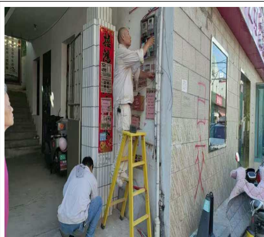
图 2-1 水电管线及时切断
